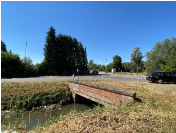
De Jeker ter hoogte van Overhaamlaan
