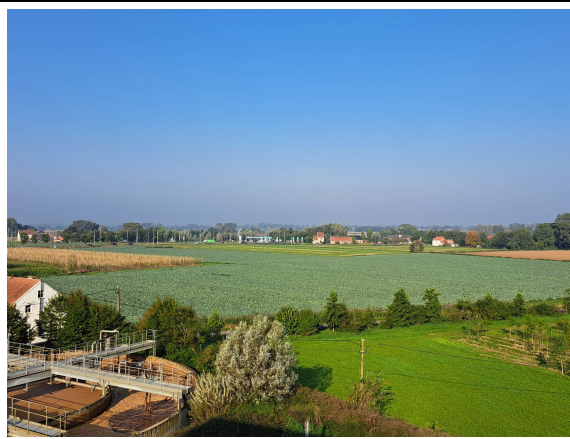
Foto van waterzuivering (3) vanop restromengebouw
