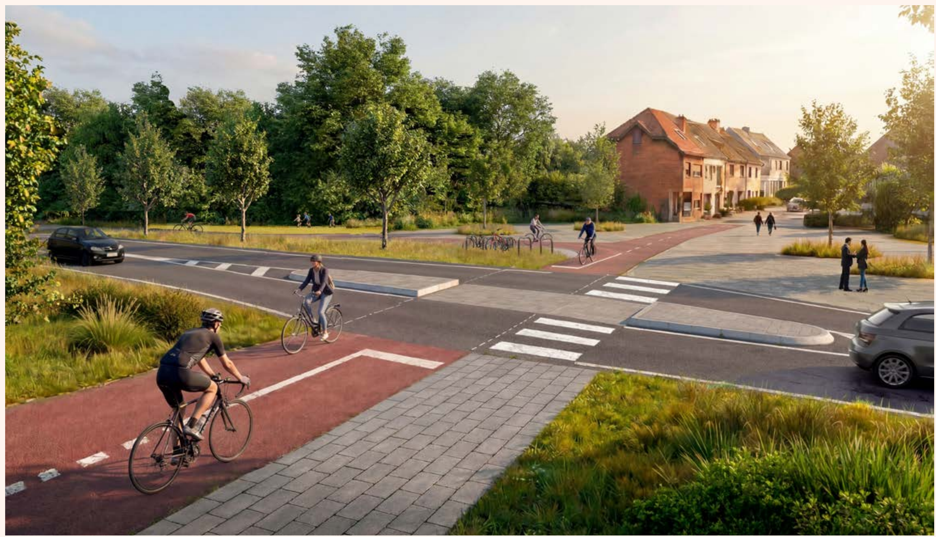
Dwarsverbinding van de Halleweg op het tunneldak over de A8. Veilige inrichting van het kruispunt met de lokale verbindingsweg.
