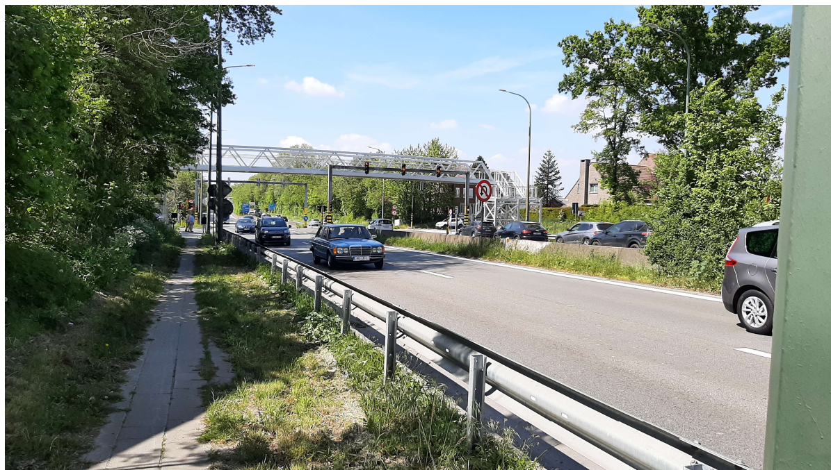
Figuur 31: Huidig wegbeeld van de A8 ter hoogte van het kruispunt Rodenemweg, voorzien van een voetgangersbrug.
