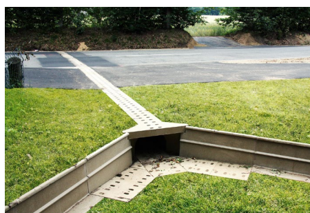
Figuur 23: Referentie van een kleine eco-tunnel, een koker met klimaatgaten ingewerkt in de rijweg van een fietspad en aangewerkt met keerwanden.
