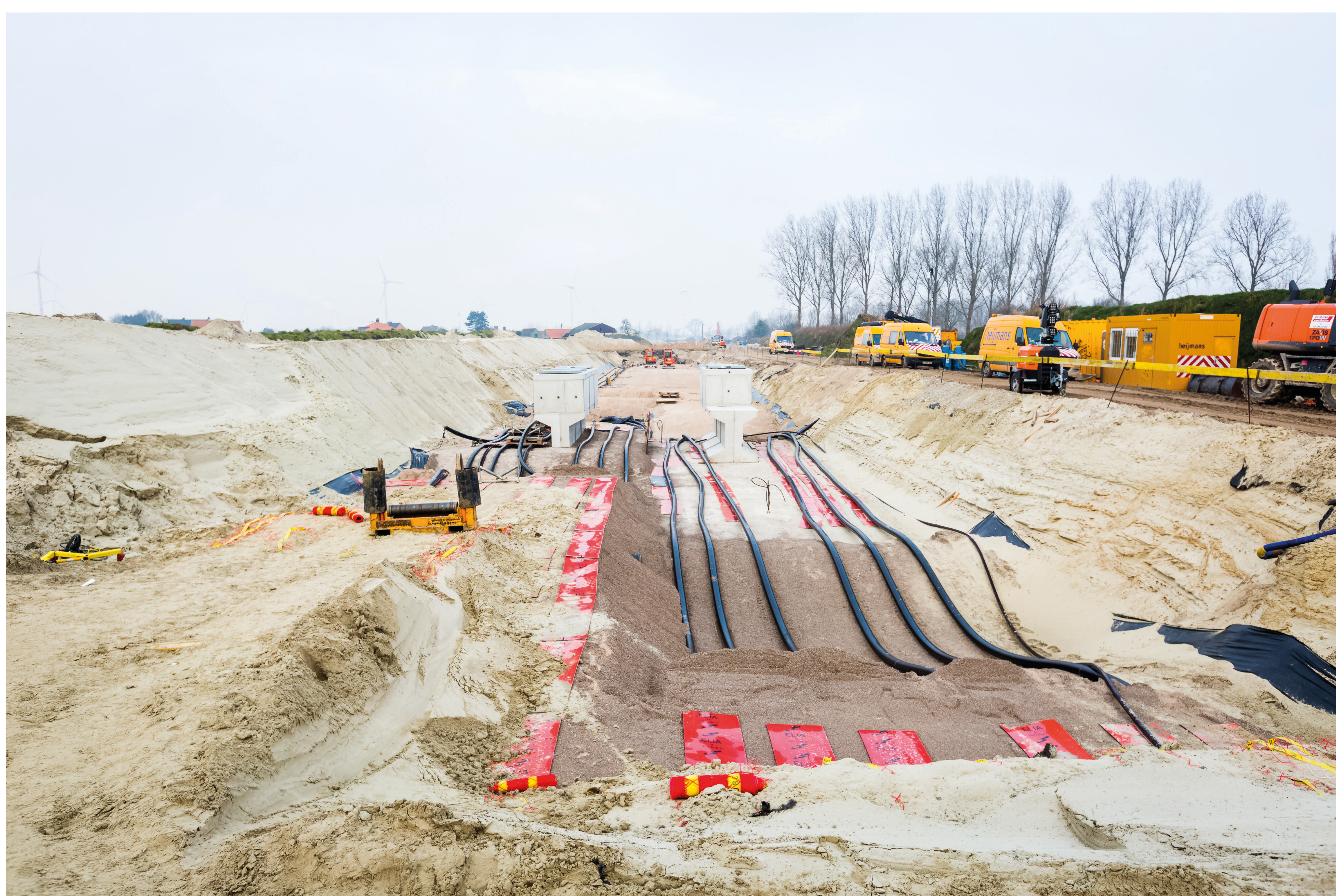
Aanleg ondergrondse kabels
