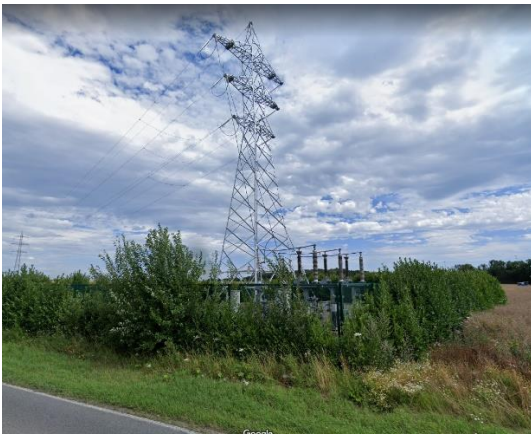
Figuur 8: voorbeeld overgangspost Les Isnes – 150 kV
