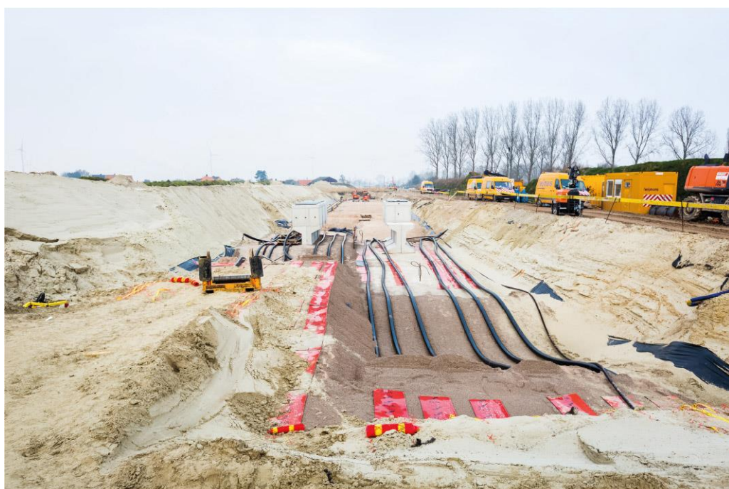
Pose de câbles souterrains
