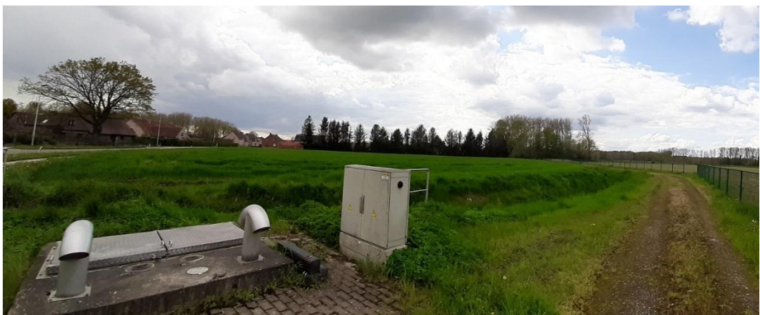
FIGUUR 6-42 ZICHT TEN OOSTEN STEVOORTSE KIEZEL/N739 (T.H.V. VERLENGDE HAAGSTRAAT)
