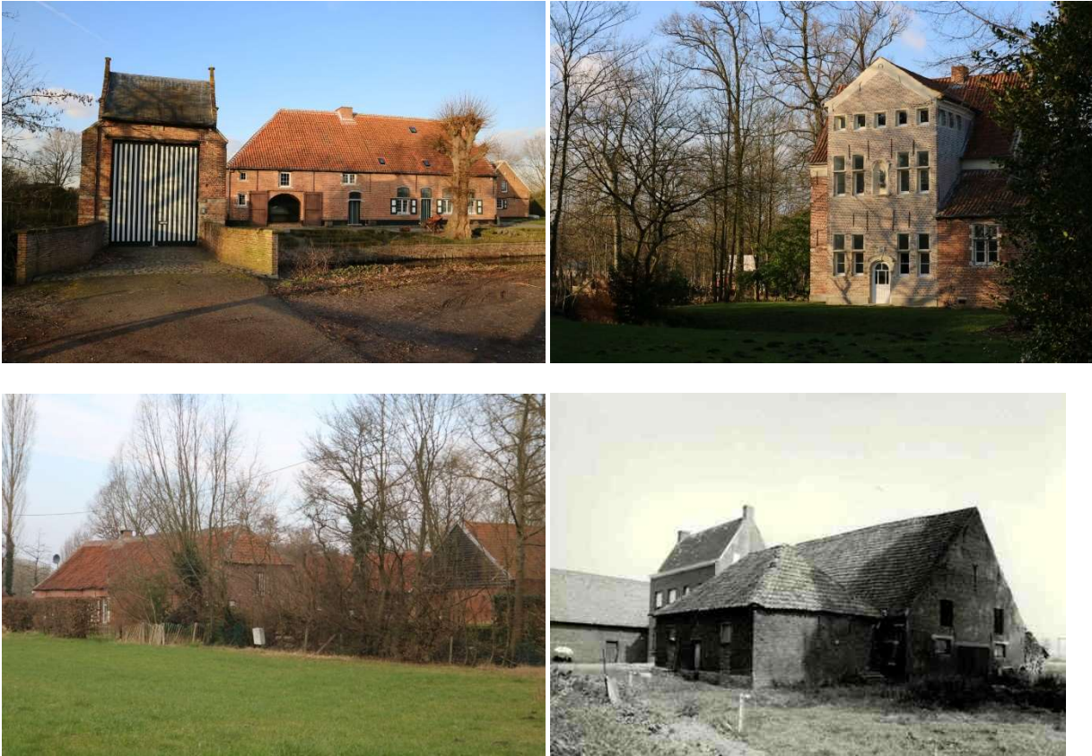
Figuur 6-3. Hoeves met bouwkundig erfgoedwaarde: Kartuizerhoeve, Jezuïetenhoeve, Hoeve Ter Haegen en hoeve met losse bestanddelen (Beeldbank Agentschap Onroerend Erfgoed, Michael Van Craen)
