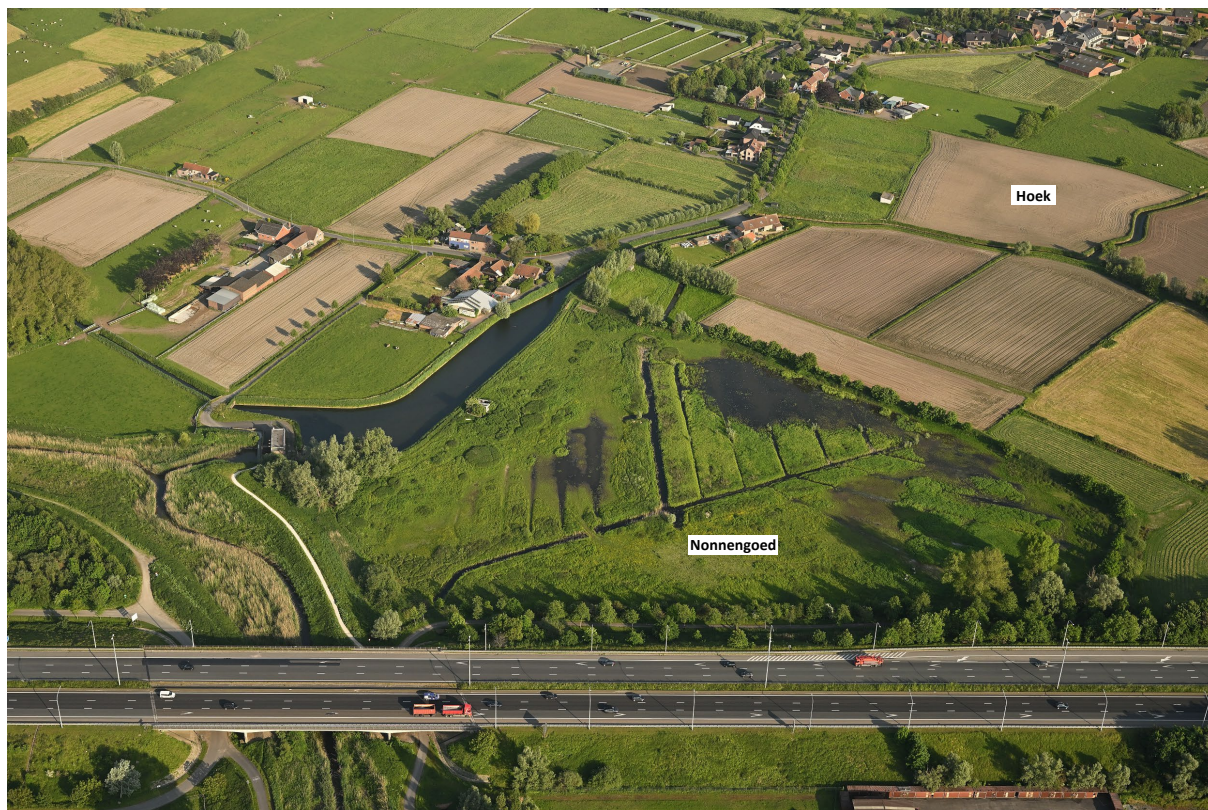
Figuur 7-25. Luchtbeeld Nonnengoed-Hoek (foto: Vilda/De Vlaamse Waterweg NV)
