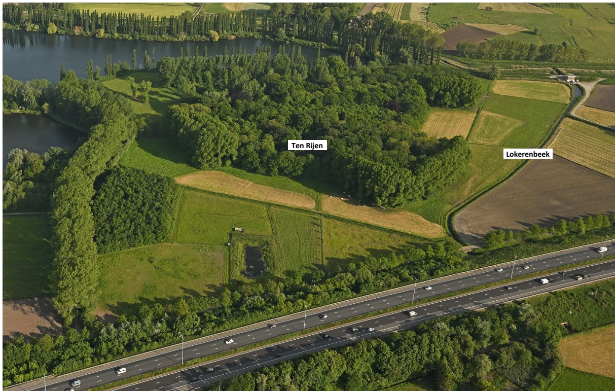
Figuur 7-19. Luchtbeeld Ten Rijen (foto: Vilda/De Vlaamse Waterweg NV)
