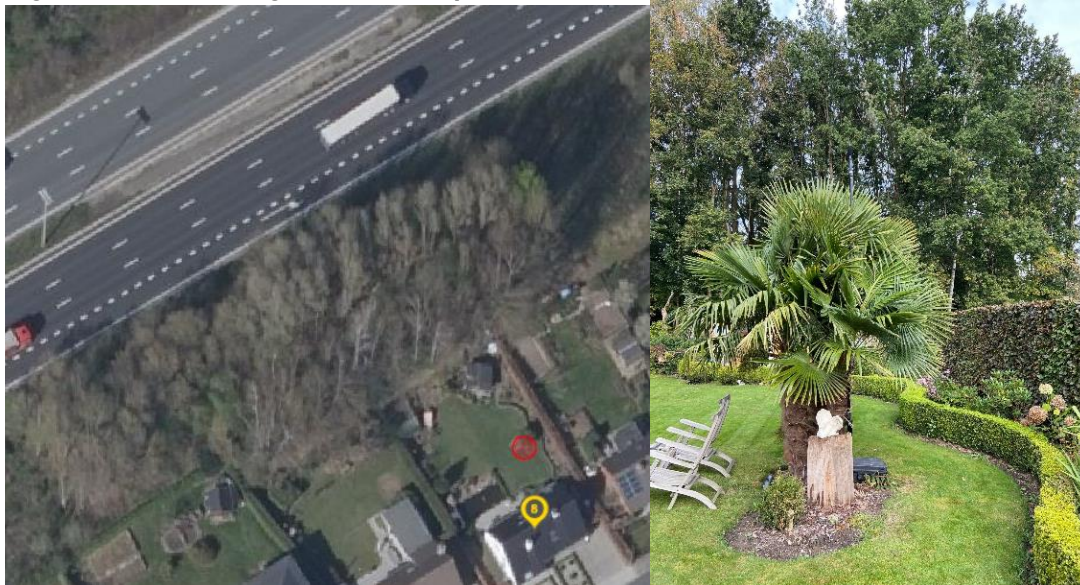
Figuur 10: aanduiding van het meetpunt met afstand tot de weg en foto van meetopstelling
