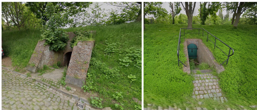
Figuur 8-18: Poterne Vestingstraat (links) (bron: Google Maps 05/2021) en poterne Kazerneplein (rechts) (bron: Google Maps 05/2021)
