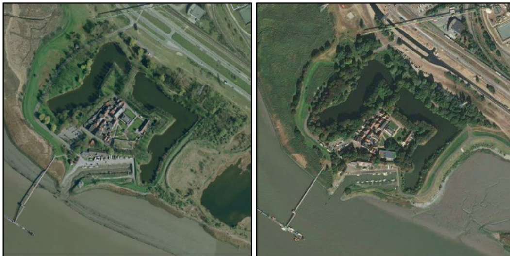
Figuur 7-3: Luchtfoto van de situatie voor ontpoldering (links, dd. 2010) en na ontpoldering (rechts, dd. 2018)
