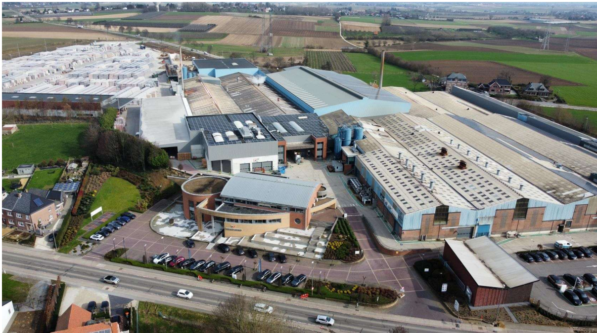
Figuur 16: Vandersanden steenfabrieken vanaf de Riemsterweg met links achteraan de uitbreiding ter hoogte van het deelplan Vandersanden omstreeks eind 2024
