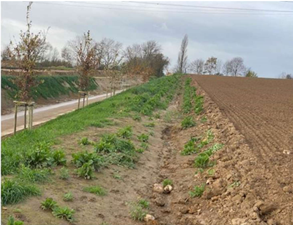
Figuur 12: Verlegde Schildstraat (holle weg) en bufferstrook van 3 meter met gracht om erosie tegen te gaan.
